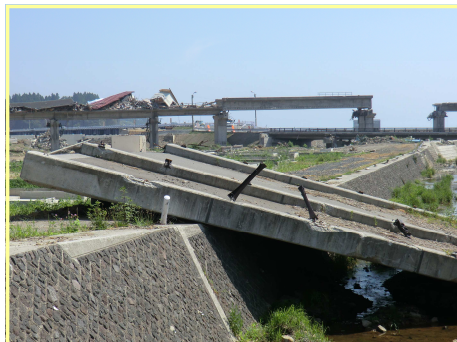
津波に押し流された高架鉄道 線路の上には、押し流された家が
